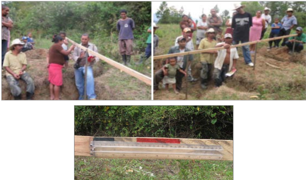
Figura 17- Instalación del extensómetro para la medición desplazamientos
