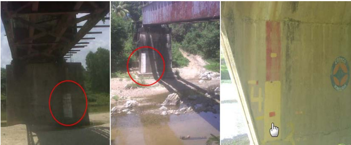
Figura 11- 4.2.2.3 Escalas pintadas en los puentes
